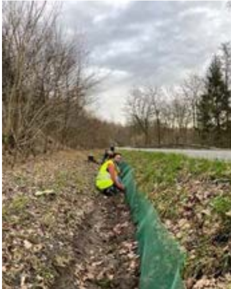
Aufbau des Krötenzaunes entlang der Möhnestraße zwischen Wamel und Völlinghausen.
