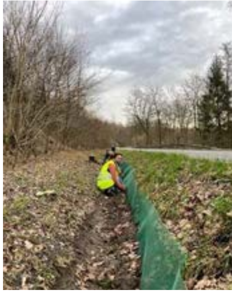
Aufbau des Krötenzaunes entlang der Möhnestraße zwischen Wamel und Völlinghausen.
